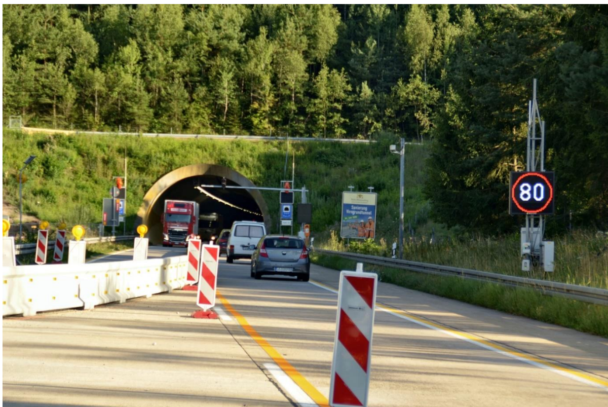
Abbildung: Tunnelsperreinrichtung Anzeigequerschnitt mit Wechselverkehrszeichen und Lichtsignalanlage (Quelle: Green Way Systems GmbH)
