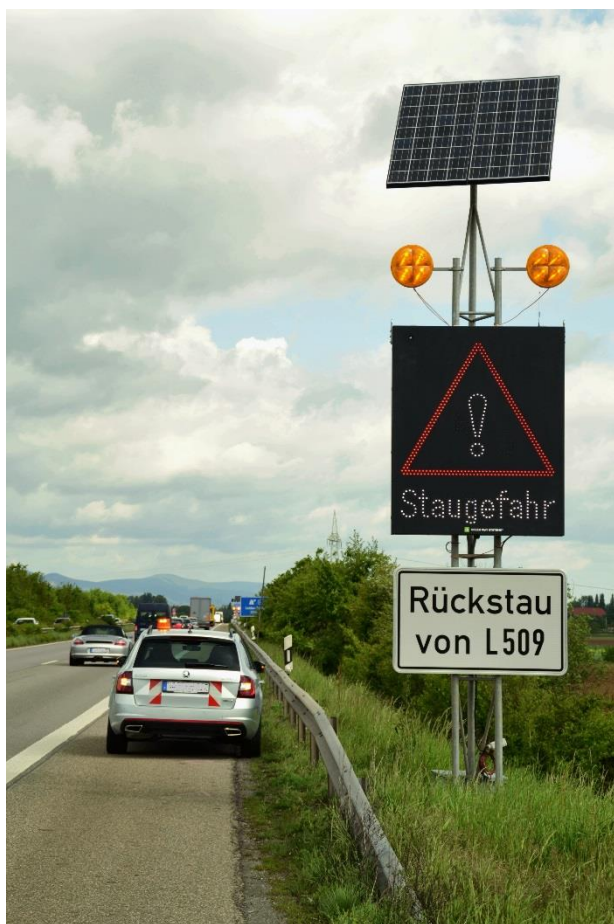
Bild 1: AQ-Standort mobile Stauwarnanlage
