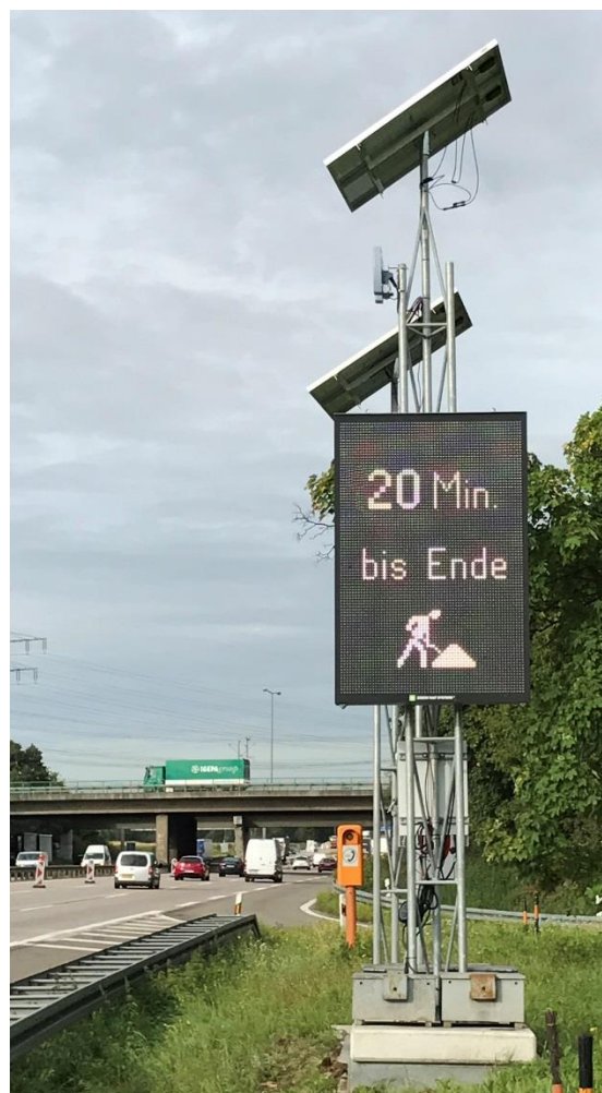
Photo 1: PMV lors de la mise en route
